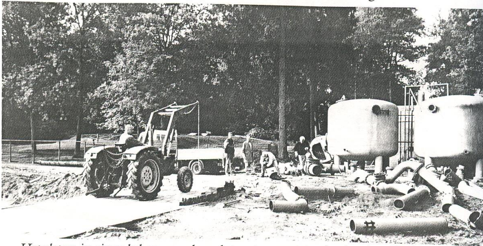
Het slopen in eigen beheer van de oude pomp en waterzuiveringsinstallatie.
